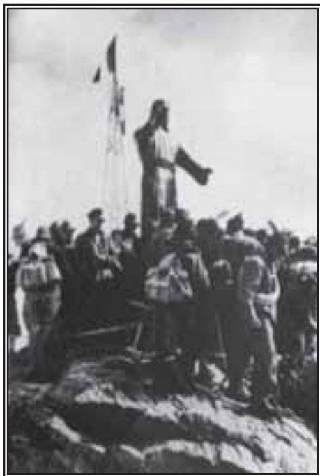
4 settembre 1955. La posa del Cristo delle Vette.
